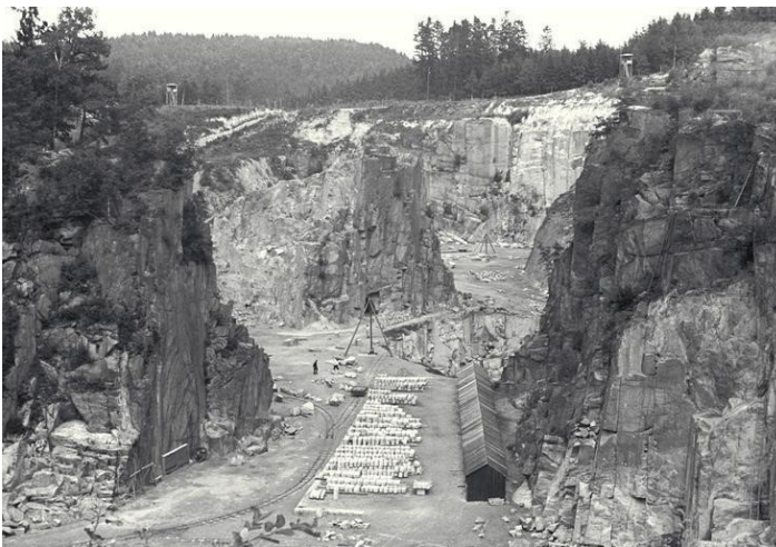
Abb. 48: Der Steinbruch Wiener Graben (KZ Mauthausen) 1941/42. 2149
