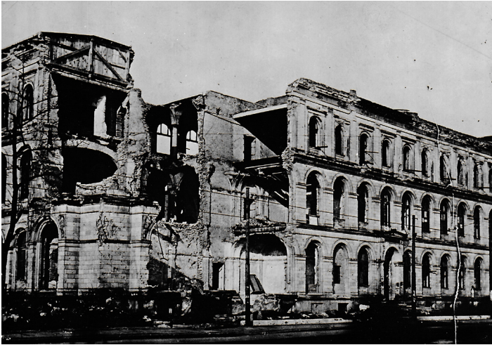
Abb. 93: Zerstörungen am Gebäude des Reichsamtes für Bodenforschung in der Berliner Invalidenstraße 44, um 1946. 3079
